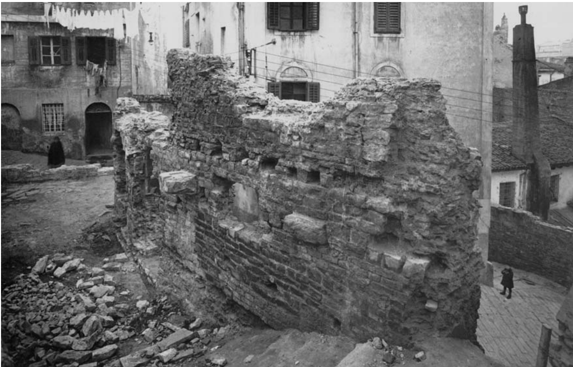
Immagine 8- Situazione prima degli scavi: le case erano costruite sui muri del teatro
