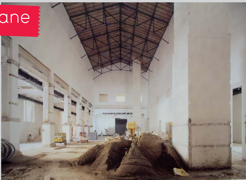
Lavori in corso al MAMbo, foto di Raffaello Scatasta
