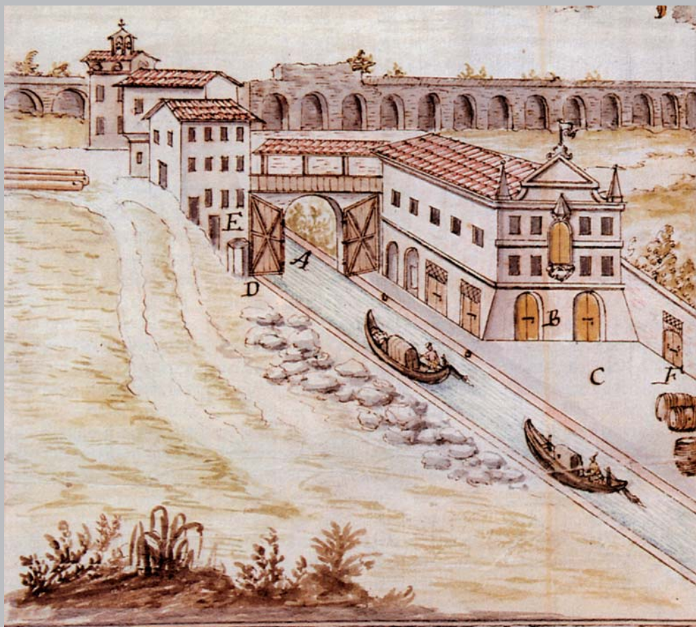
Edifici e strutture del Porto Naviglio di Bologna, disegno del XVII secolo
