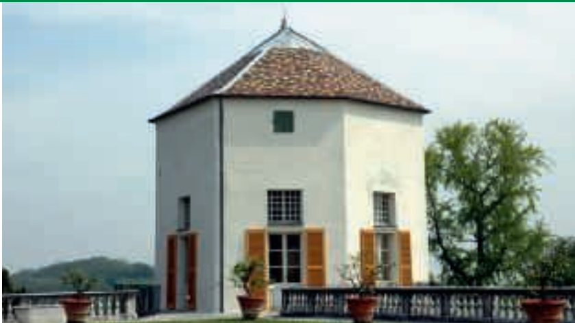
TORRE DEI VENTI, DOPO IL RESTAURO CONSERVATIVO E STRUTTURALE. IL CASTELLO È STATO ACQUISITO DAL FAI NEL 1988 E APERTO AL PUBBLICO NEL 1989.
