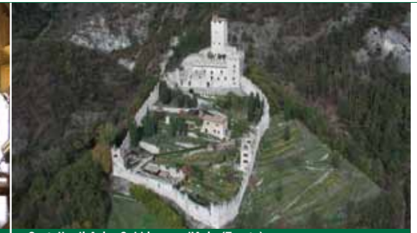
Castello di Avio, Sabbionara d'Avio (Trento)
